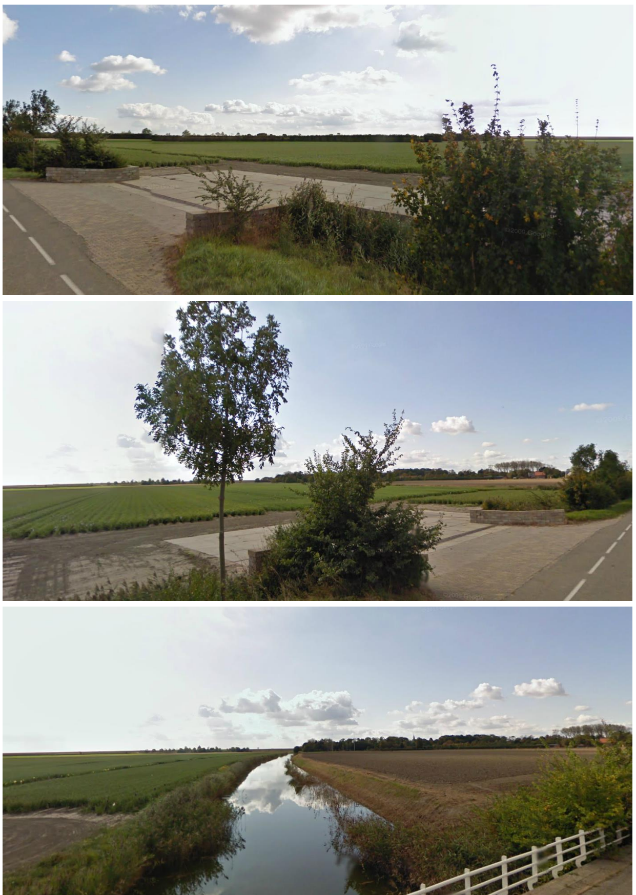
Figuur 5: Foto's bestaande situatie
