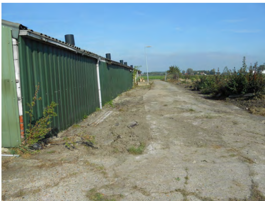
Onderzoekslocatie tijdens uitvoering veldwerk
